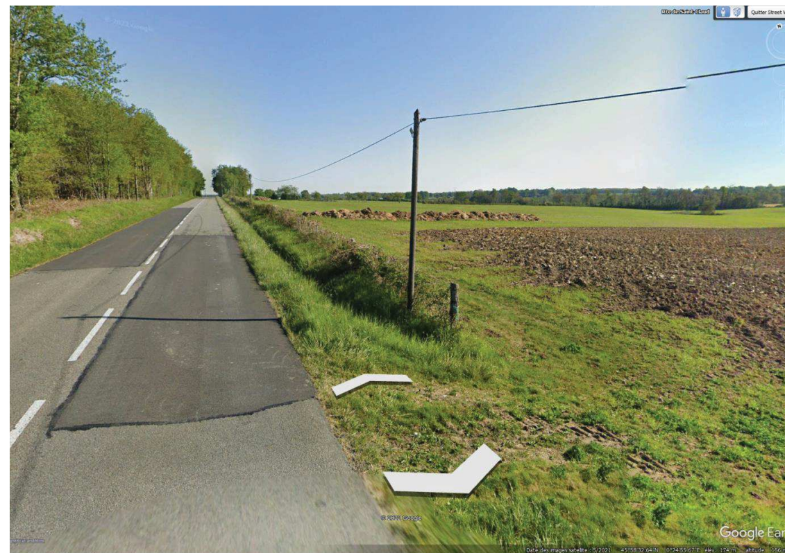
Photo 1 – Vue du fossé depuis le sud de la RD28
